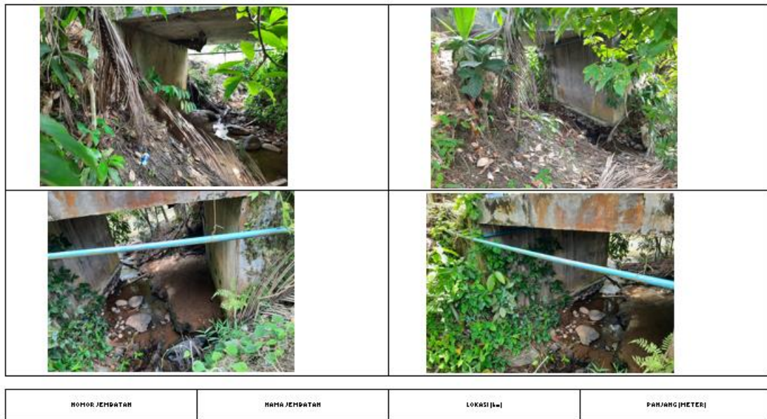
Gambar 7. Foto kondisi jembatan
