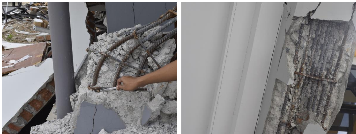
Gambar 5. Penulangan Yang Tidak Memadai
