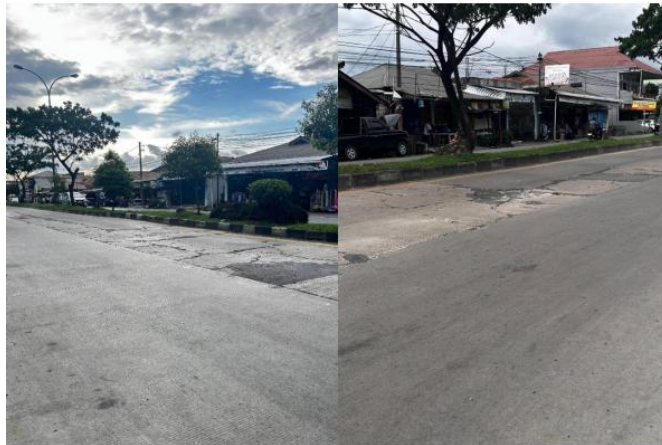
Gambar 7. Kondisi lapangan sta 2+100 dan sta 2+200
