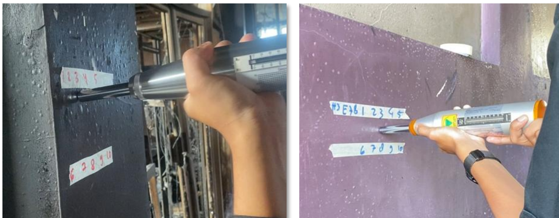
Gambar 9. Hammer Test Pada Elemen Struktur Bangunan
