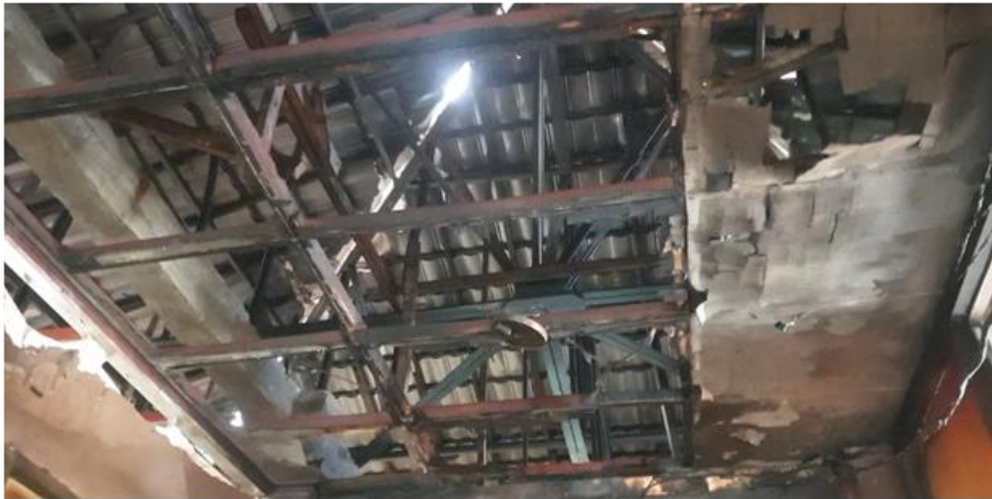
Gambar 6. Struktur Atap Utama Menggunakan Rangka Baja (Truss)
