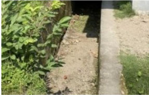
**Gambar 4.** Saluran Beton dengan Permukaan yang Dihaluskan
